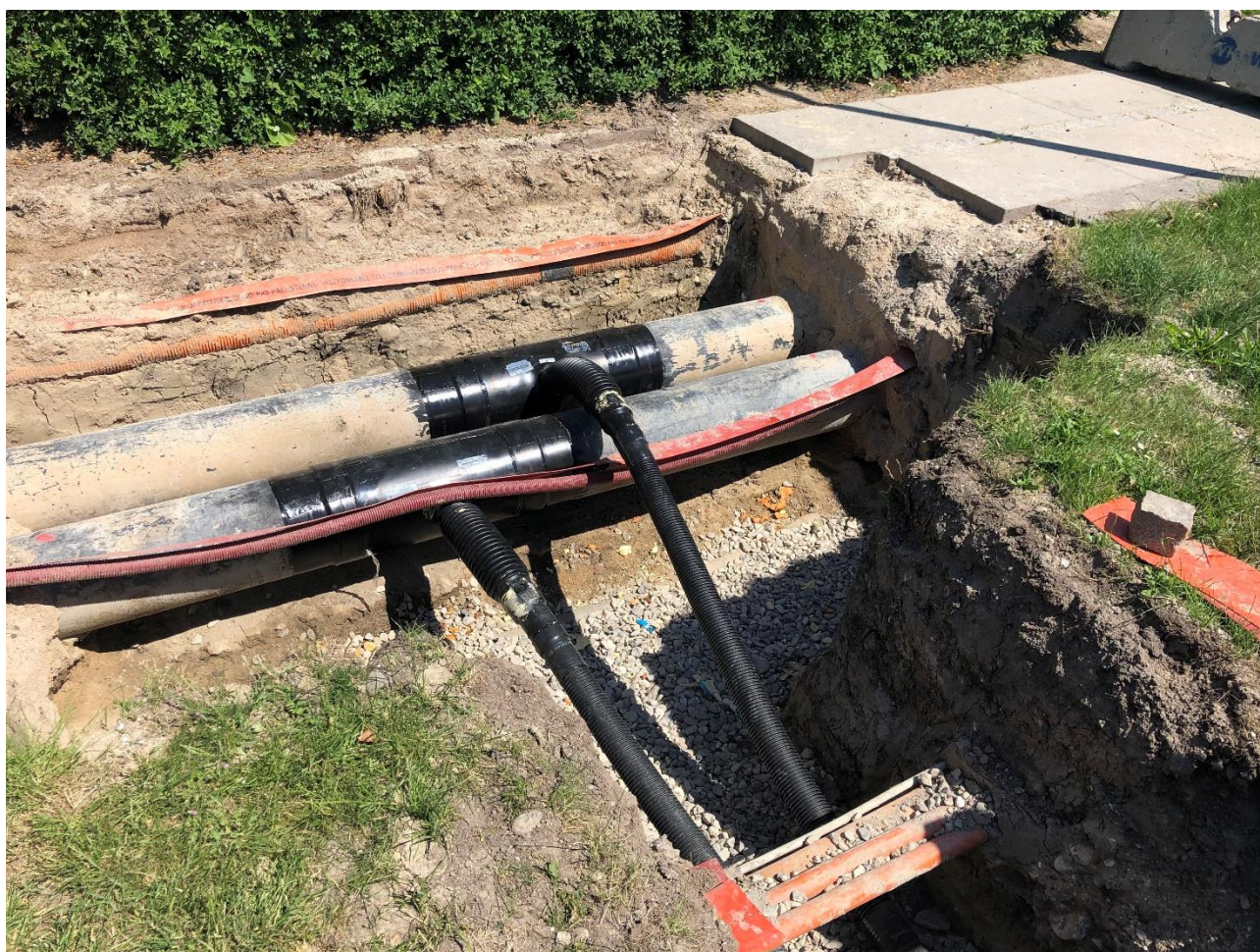
Etablering af stikledning hos ny kunde
