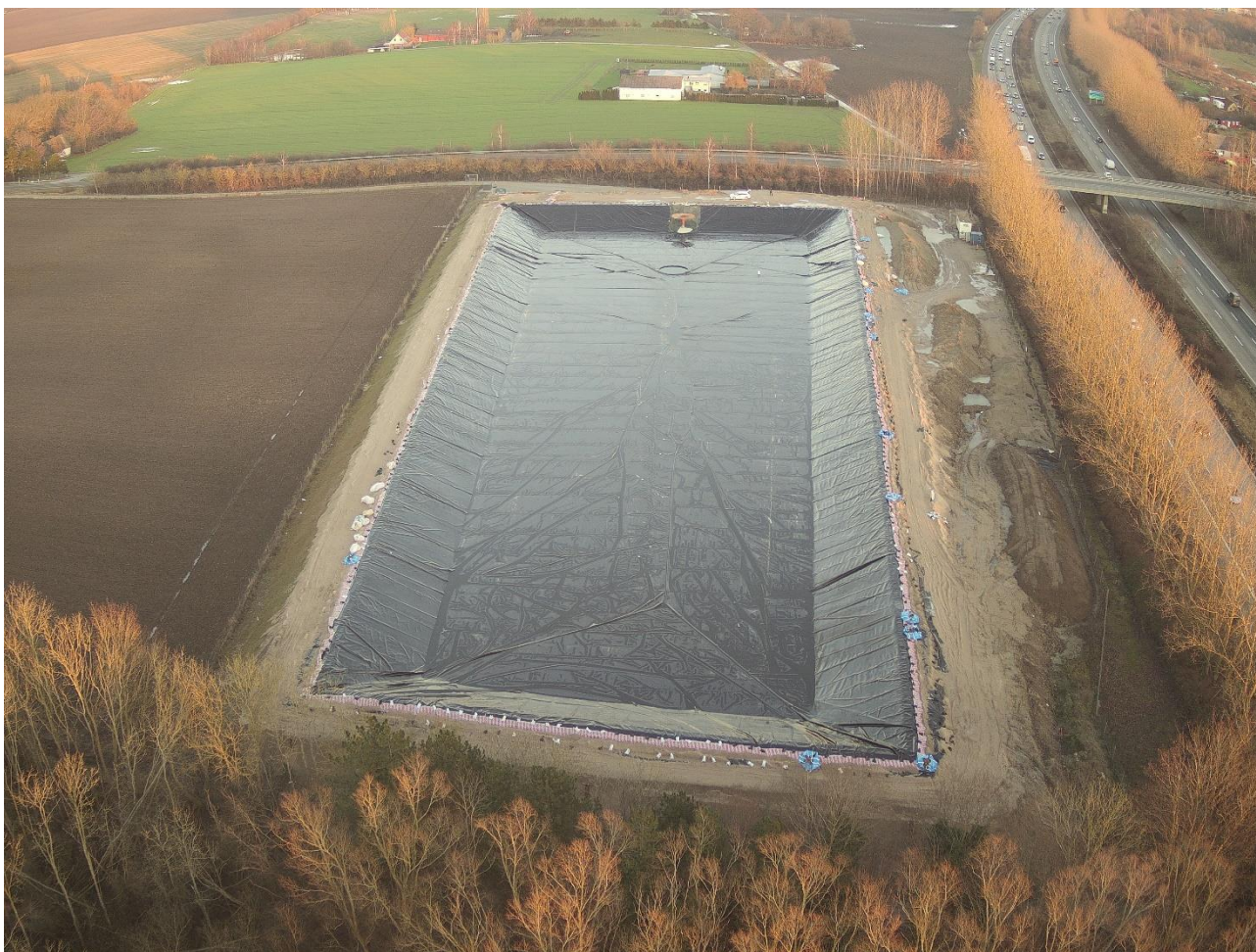
Der fyldes vand på damvarmelageret
