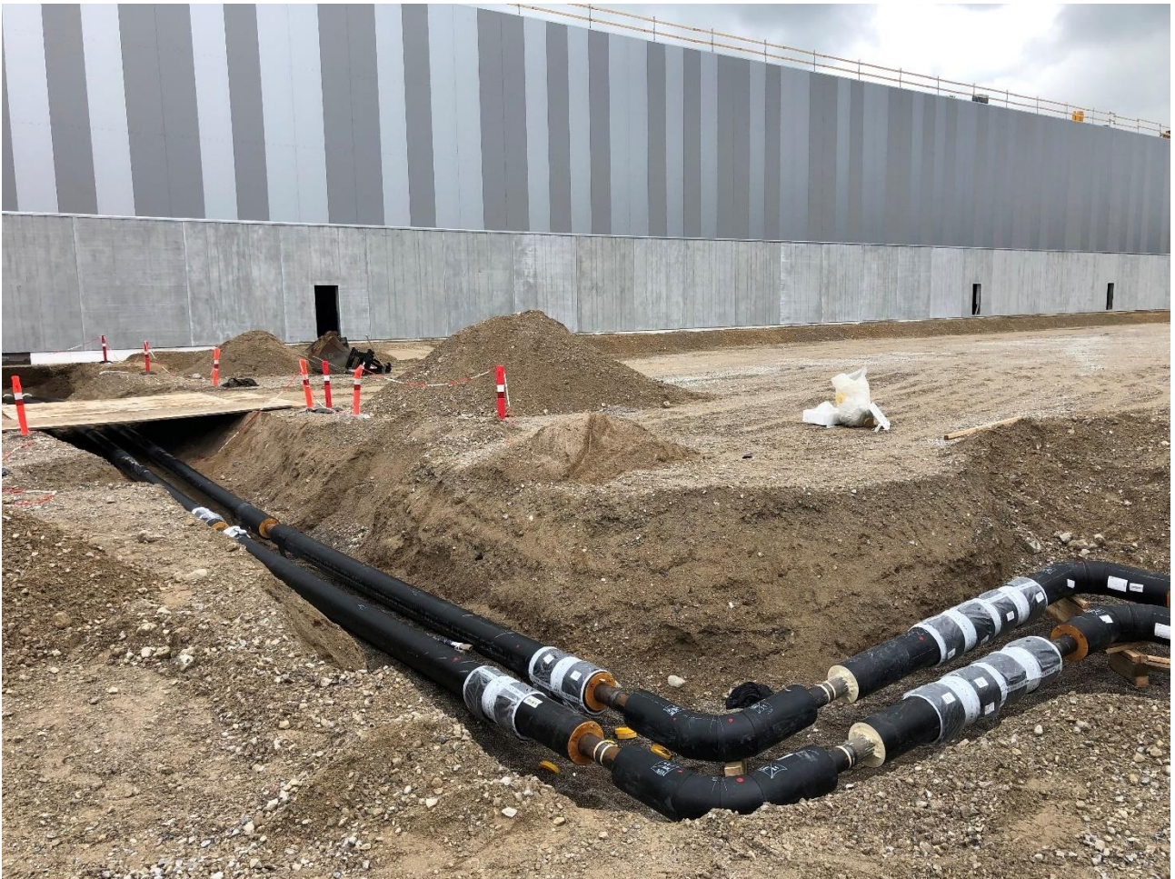
Rør til DSV hal 2
