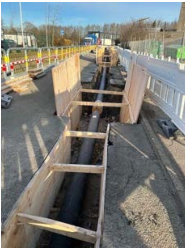
Etablering af forsyningsledninger i Rundageren
