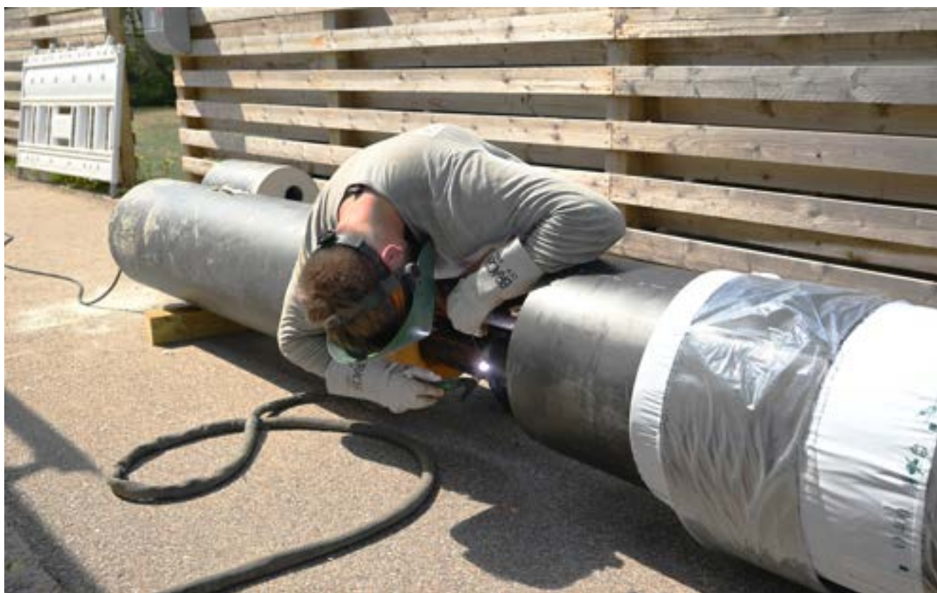
Svejsning af rør
