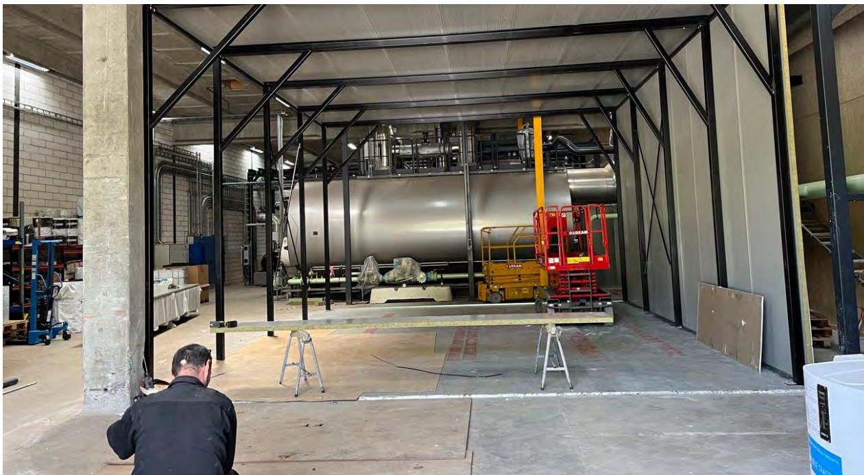
Her gøres klar til opstilling af endnu en varmepumpe, der skal aftage overskudsvarme fra GlobalConnect
