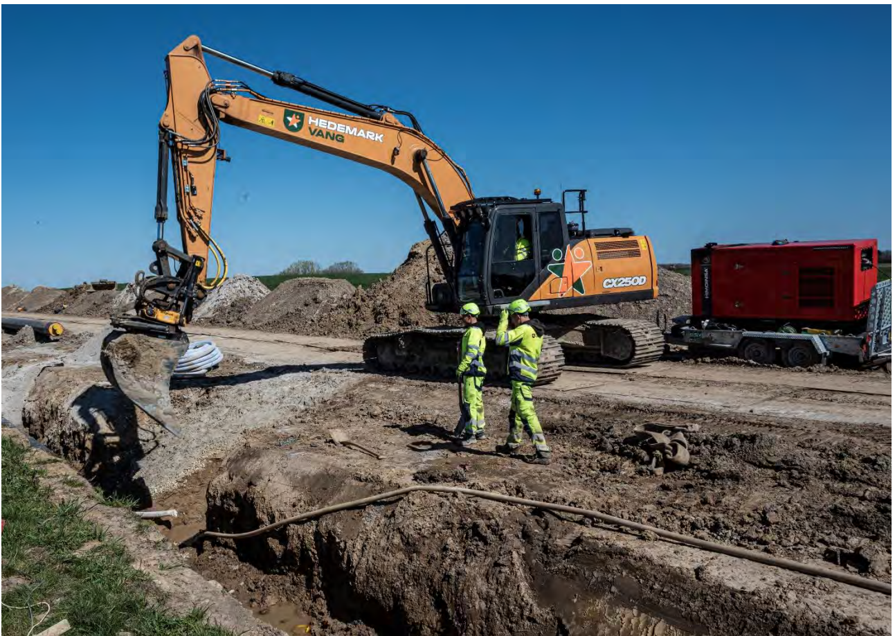
Etablering af fjernvarme kræver et kæmpe anlægsarbejde
