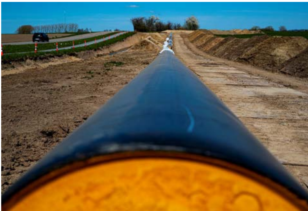
Forsyningsledning til Sengeløse
