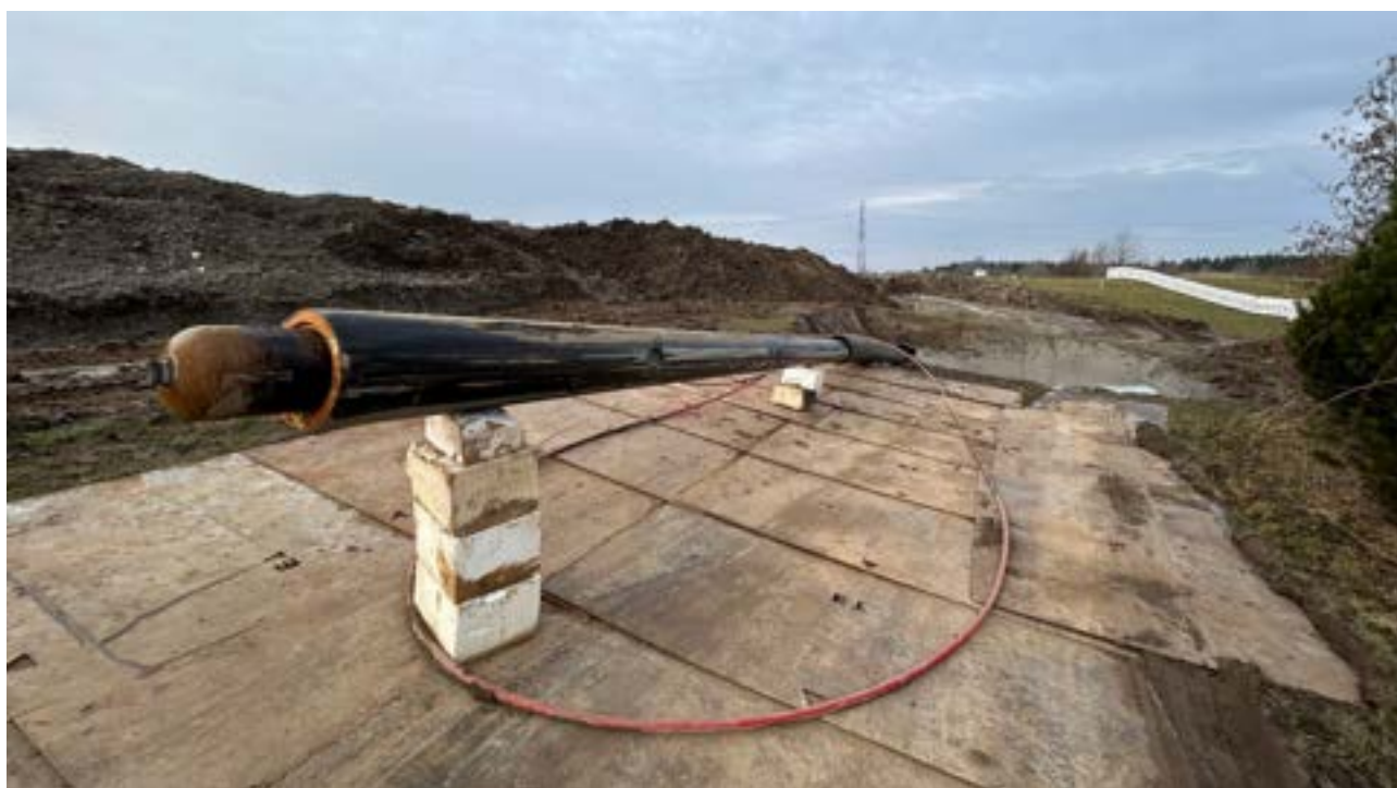
Styret underboring på Sydvej
