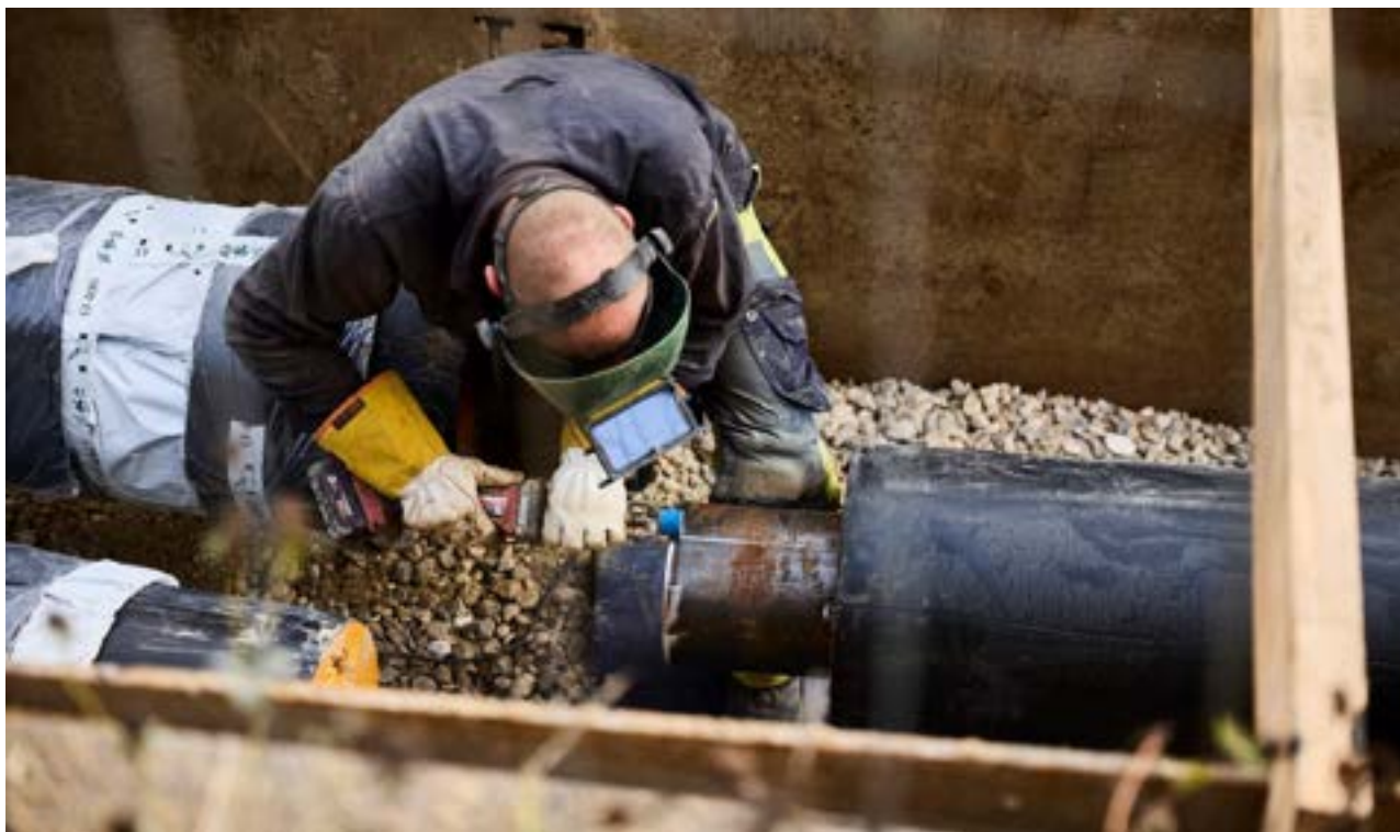
Svejsning af rør - byggeriet ved Selsmosen
